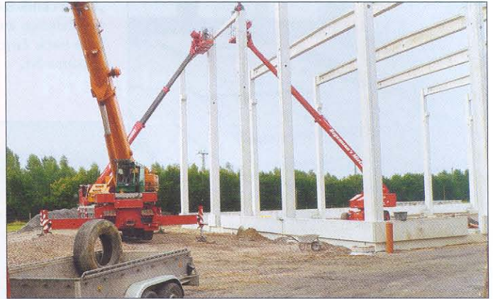
Neue Halle mit 14 m Oberhöhe in der Aufbauphase
